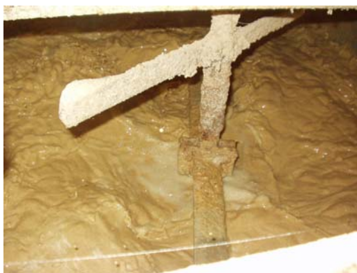
Figura 90 – Miscelazione della broda all'interno di una vasca di preparazione
